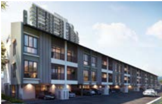
乐居苑 - 共有 72 个单位的联排住宅。
